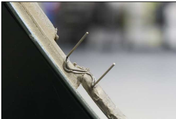
Abbildung 8: Stahldraht-Klammer zur Stabilisierung
